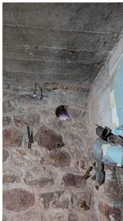
Figure 2 : Percement pour ventilation
